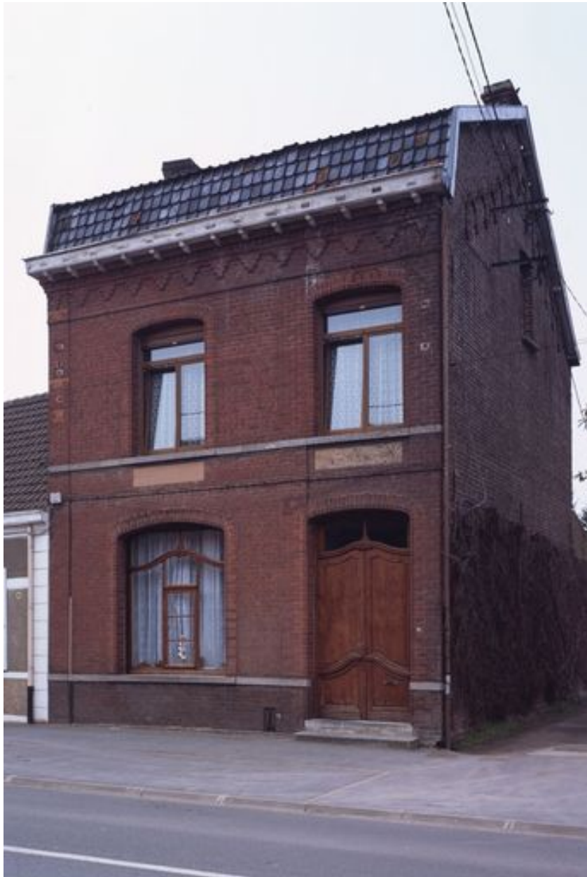
Vue générale de la maison possédant une fenêtre au châssis chantourné.
