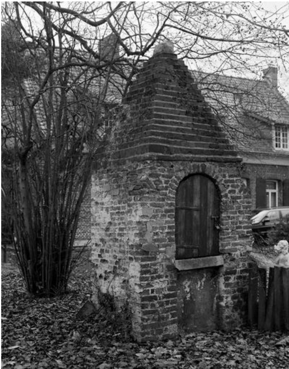
Vue générale du puits A.
