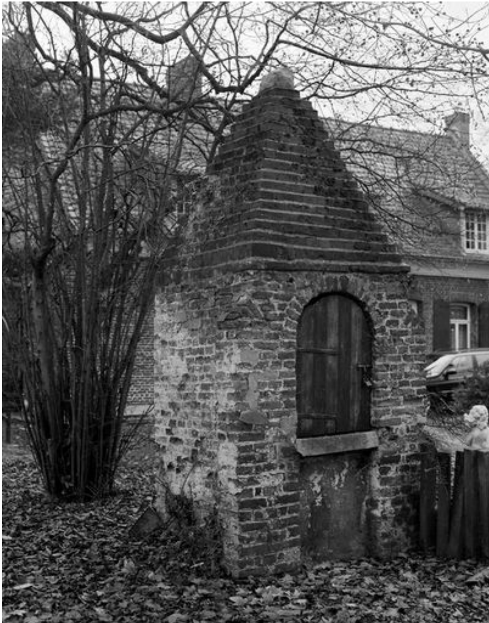
Vue générale du puits A.
