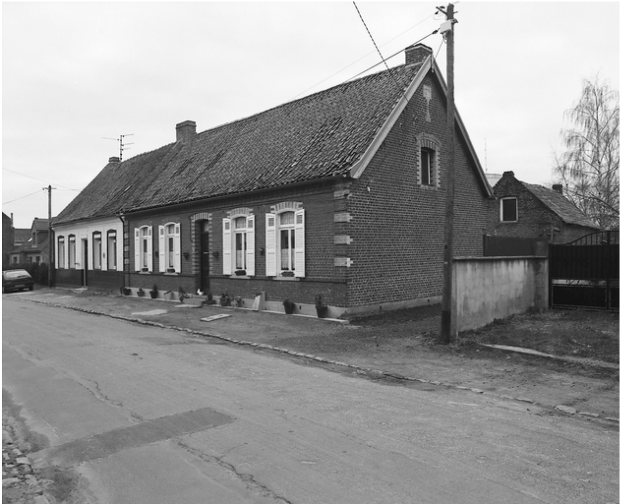
Maisons en alignement rue de la Chapelle.
