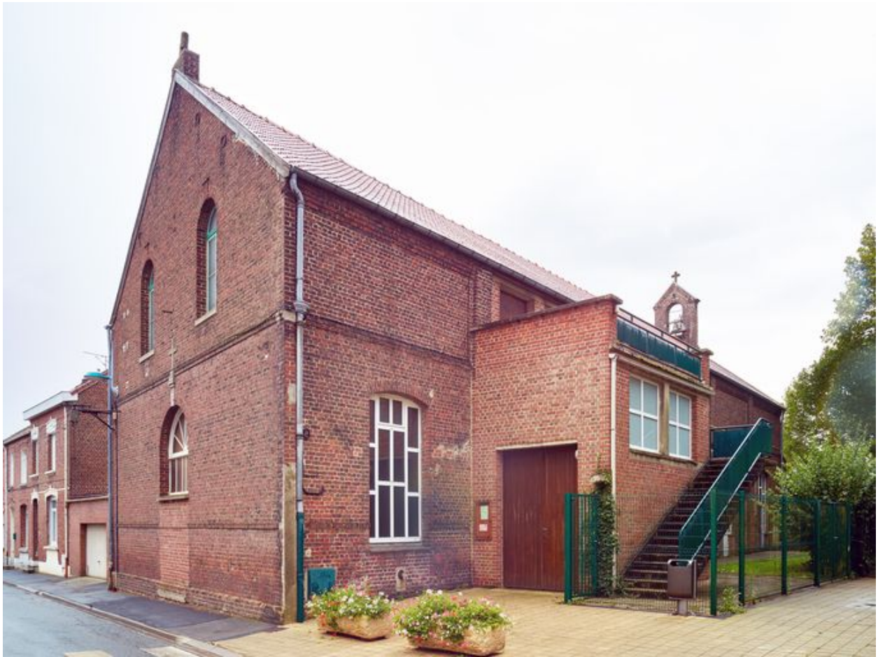
Élévation antérieure de l'église, de trois quart.
